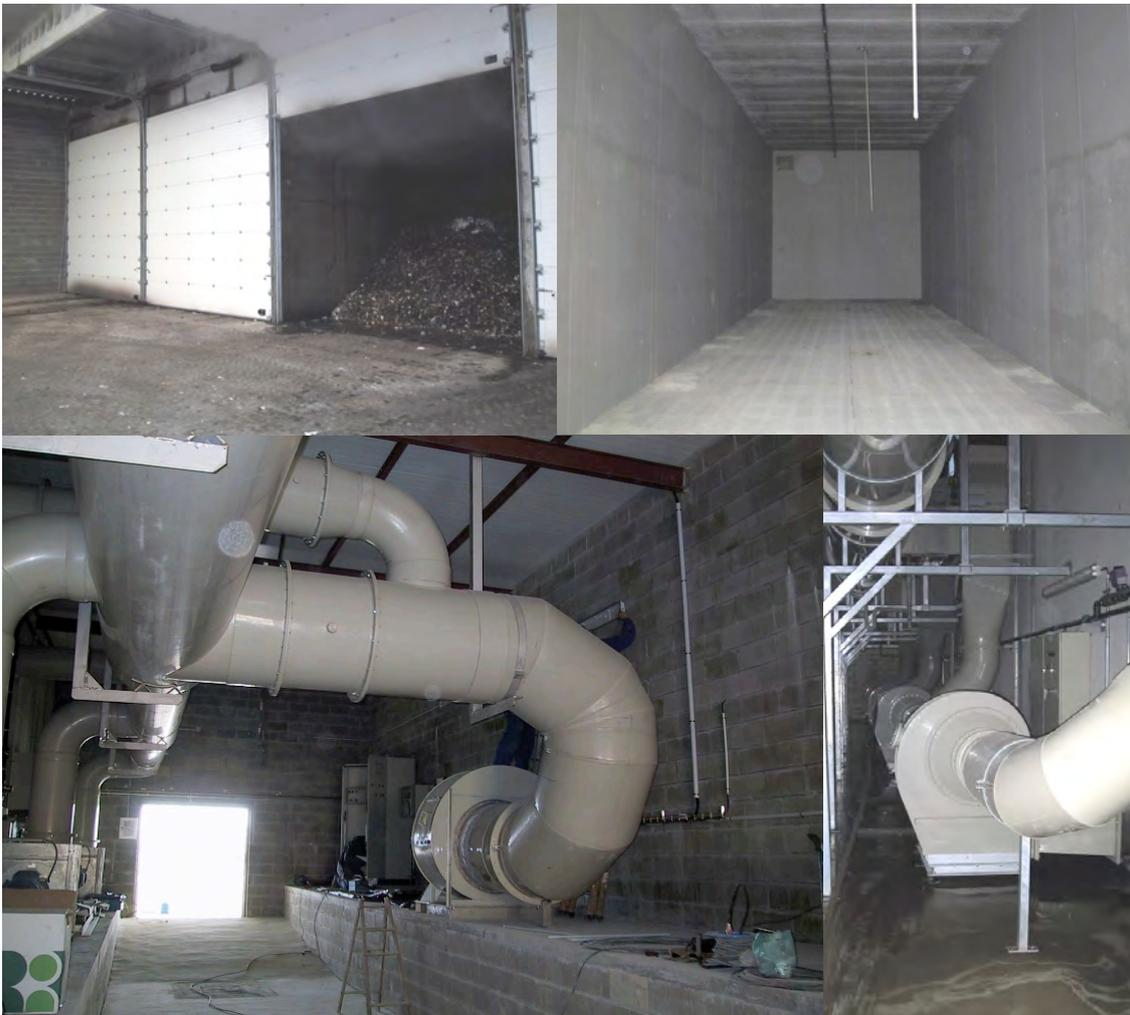
La ventilación se efectúa a través de un falso suelo perforado, ya sea por depresión (aspirado) o por sobrepresión (soplado), pudiendo disponerse la
