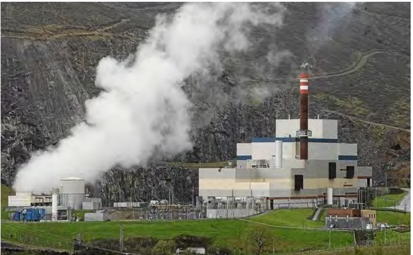
Planta Incineradora de Zabalgarbi en Guipúzcoa
