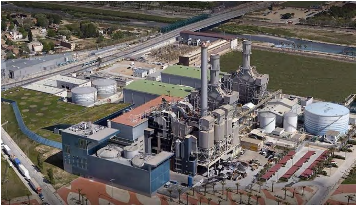
Planta de tratamiento de residuos de Sant Adrià del Besos (Barcelona)
