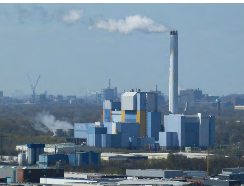
Moderna Planta Incineradora de Residuos en Oberhausen. RFA
