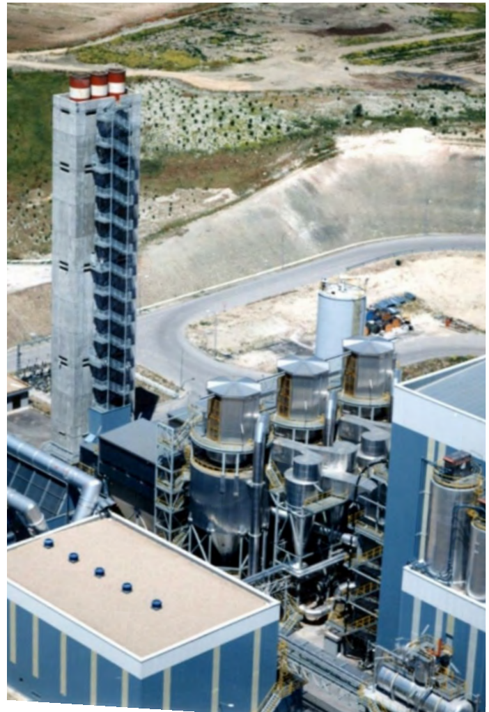
Planta incineradora Las Lomas, Madrid
