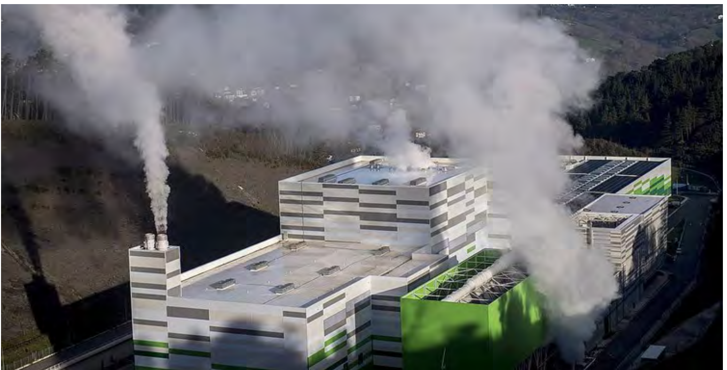
Incineradora de Zubieta (Guipuzcoa)
