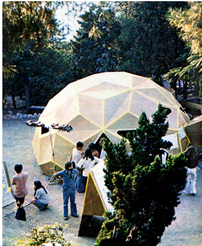
Cúpula Geodésica realizada en cartón ondulado durante las Jornadas libertarias de Barcelona, en el Park Guell en 1977
