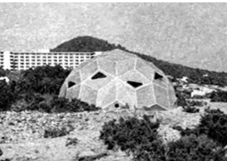
Geodésica de cartón ondulado realizada por el Colectivo de autoconstrucción y TARA en Ibiza, verano de 1977
