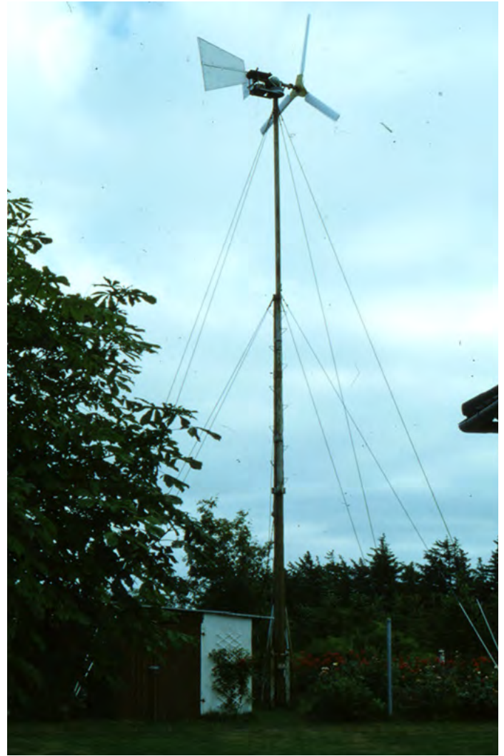
Aerogenerador Ulborg (Dinamarca)
