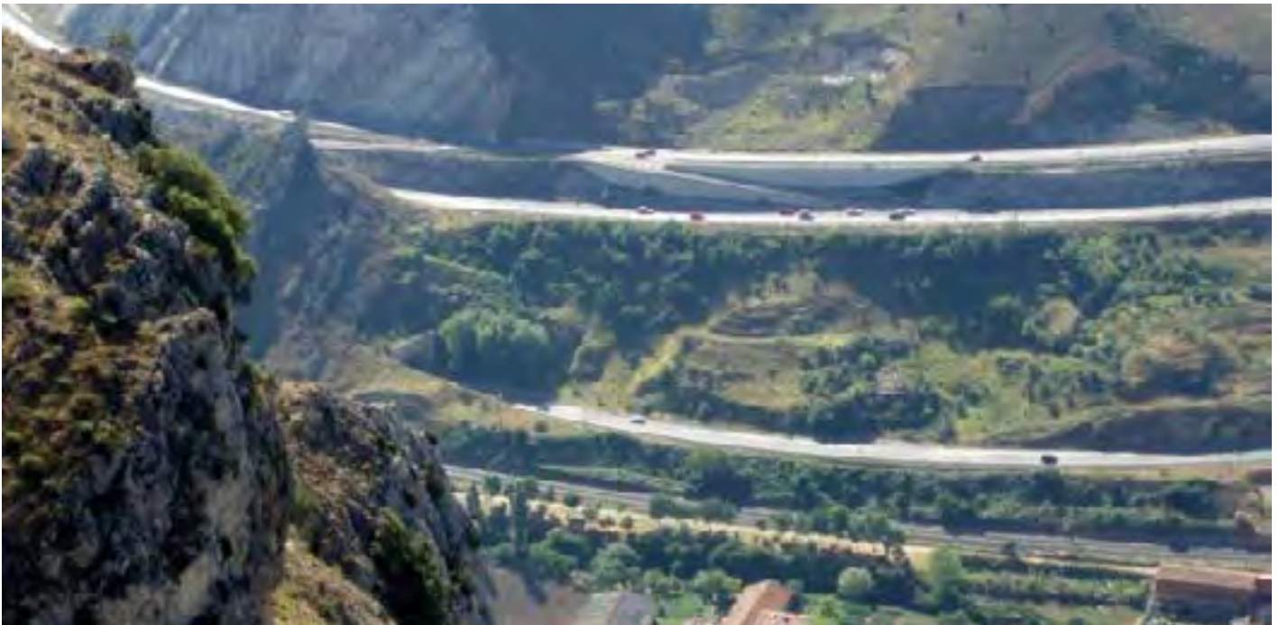
Desfiladero de Pancorbo con el trazado actual de la Autopista
