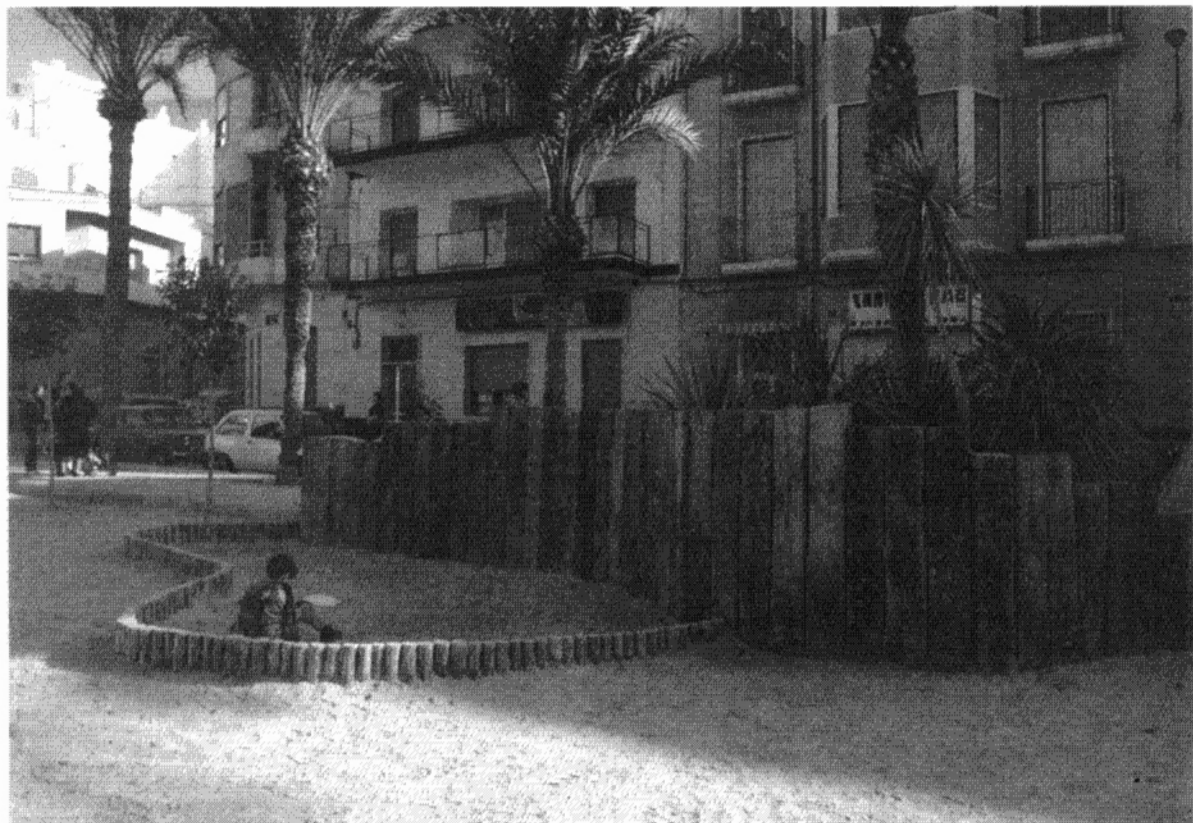
Empleo ejemplar de traviesas de ferrocarril recuperadas en una plaza de Barcelona
