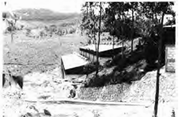
Compostador de materia orgánica procedente de la recogida selectiva de basuras en Ciudad de Guatemala. El compost de la construcción superior se voltea a la interior.
