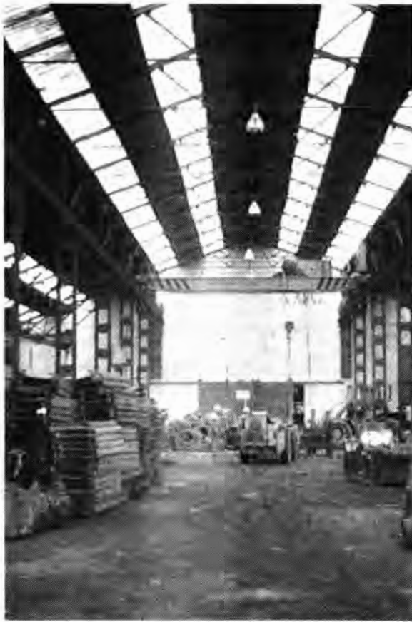
Nave sin uso de Potasas de Navarra, en la que se propuso la instalación de la planta piloto
