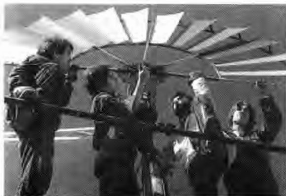
Instalación del aerogenerador en la Exposición de Antsoain
