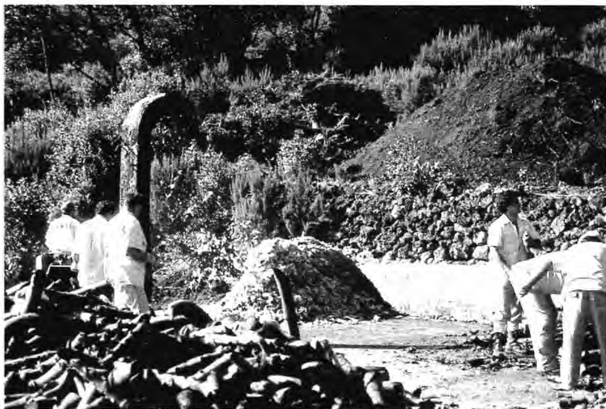
Compostaje experimental de restos orgánicos domiciliarios, de platanera, de granjas e industriales (maderas) en Mazo. Forma parte del Plan Integral de Residuos Sólidos de la Isla de La Palma. 1997.
