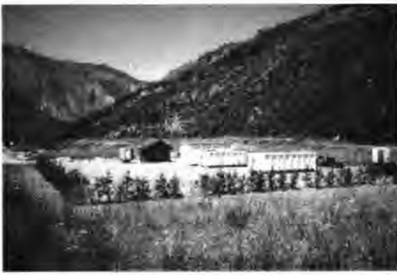
Déchetterie a un Km de St. Michel de Marne (Savoie, Alpes franceses) de 2.000 habitantes, con horas de apertura y vertedero de escombros.
